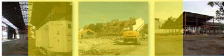
Désamiantage Ferrières Guyot 1 Montreuil Gennevilliers Barbusse
