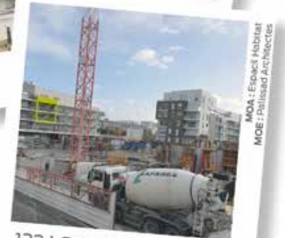
123 LOGEMENTS ZAC Chandon
