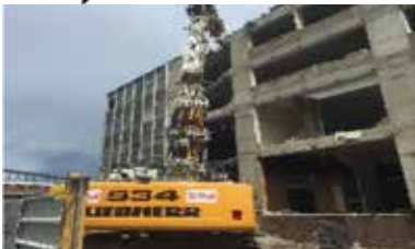
Démolition grand bras 24 m - Montreuil
