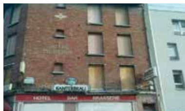
Sécurisation d'un bâtiment
