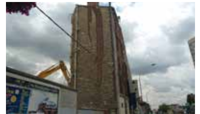
Démolition R+5 Semag
