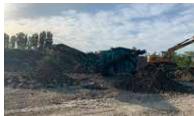
Criblage - Optimisation des terres
