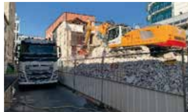
Démolition pelle 73 t - Montreuil
