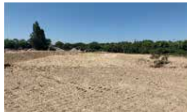
Terrassement et aménagement 60 000 m 2 - Gennevilliers
