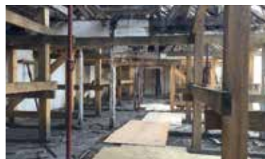
Étaieement d'un bâtiment
