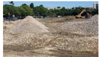
Piscine Olympique Aulnay démolition et dépollution 11 000 t
