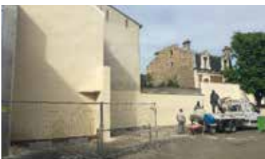
Protection enduit après démolition
