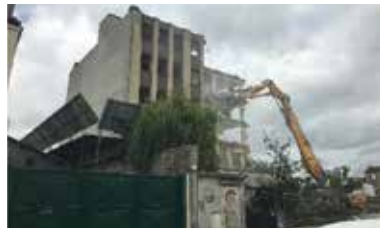
Démolition grand bras 28 m - Aubervilliers
