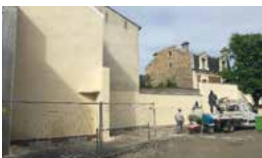
Protection enduit après démolition
