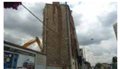
Démolition R+5 Semag
