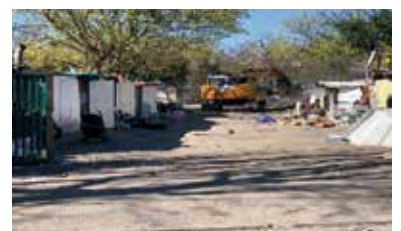
Sécurisation installation illicite
