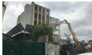
Démolition grand bras 28 m - Aubervilliers
