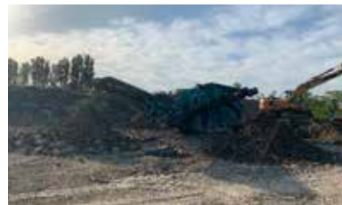
Criblage - Optimisation des terres
