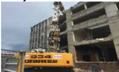
Démolition grand bras 24 m - Montreuil
