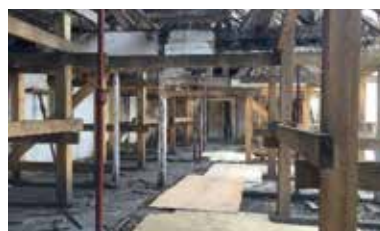
Etalement d'un bâtiment
