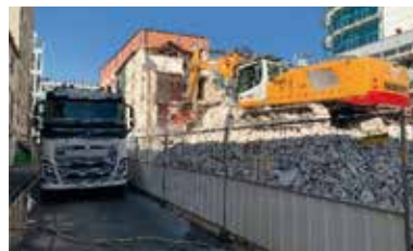
Démolition pelle 73 t - Montreuil
