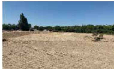
Terrassement et aménagement 60 000 m 2 - Gennevilliers
