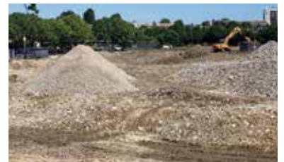
Piscine Olympique Aulnay démolition et dépollution 11 000 t
