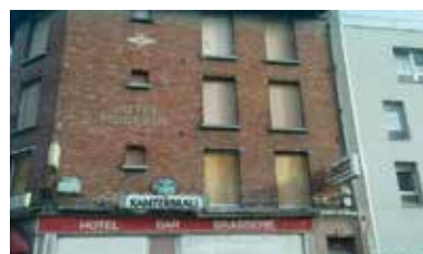
Sécurisation d'un bâtiment
