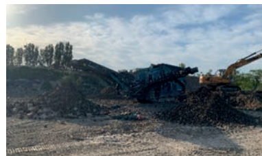
Criblage - Optimisation des terres
