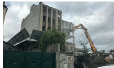
Démolition grand bras 28 m - Aubervilliers
