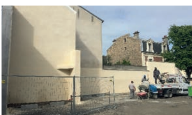
Protection enduit après démolition
