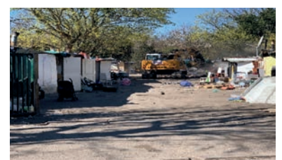
Sécurisation installation illicite
