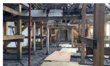
Etalement d'un bâtiment
