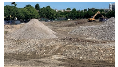
Piscine Olympique Aulnay démolition et dépollution 11 000 t
