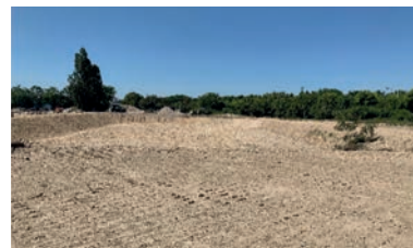
Terrassement et aménagement 60 000 m 2 - Gennevilliers
