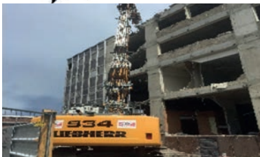
Démolition grand bras 24 m - Montreuil
