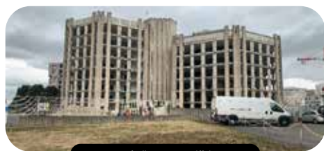
Créteil : 3 Tours Eiffel
