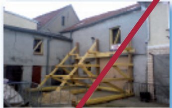
Contraventement S. CEDAT
